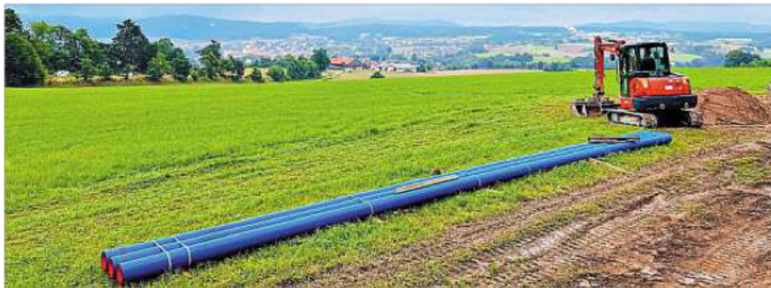
Die Sanierung der Hauptleitung von Erzhäuser nach Neunburg war heuer die größte Investition der Nord-Ost-Gruppe. Foto: Werner Schärtl
